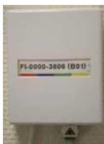
Figure 8 : FTTE passif NRO - exemple de PTO
